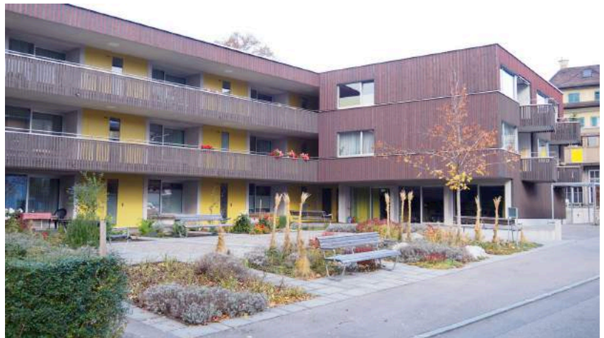
Alterswohnungen Lanzellenweg, 2014 (Wohnzone W3/2.4)
