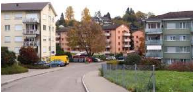
Ältere Mehrfamilienhäuser Obere Matt
