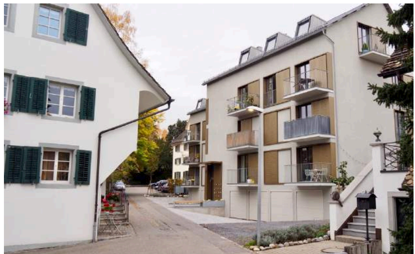
Neubau in der Kernzone Ötikon
