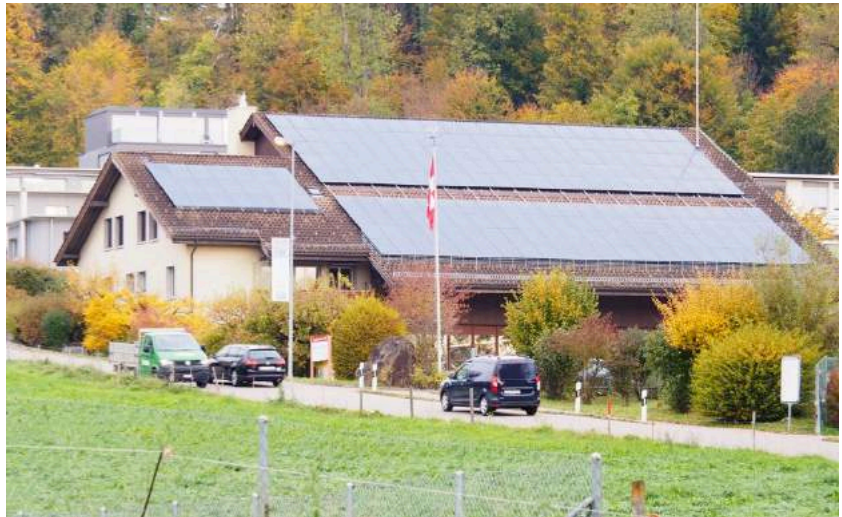
Solaranlage Werkhof Töbeli
