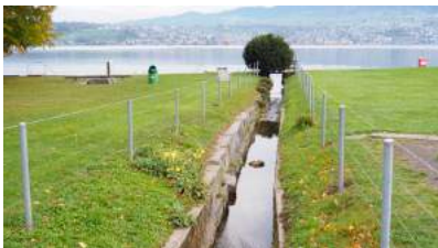
Kanalisierter Bach Villa Sunneschy
