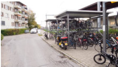
Zweiradabstellanlage am Bahnhof Stäfa
