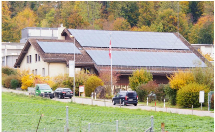
Solaranlage Werkhof Töbeli
