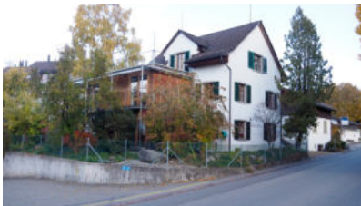
Nachverdichtung an der Dorfstrasse
