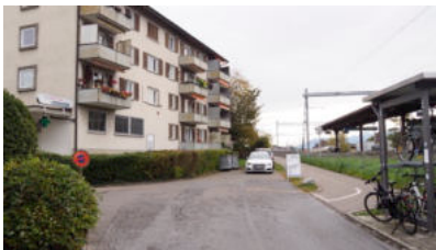
Altbauten beim Bahnhof Stäfa
