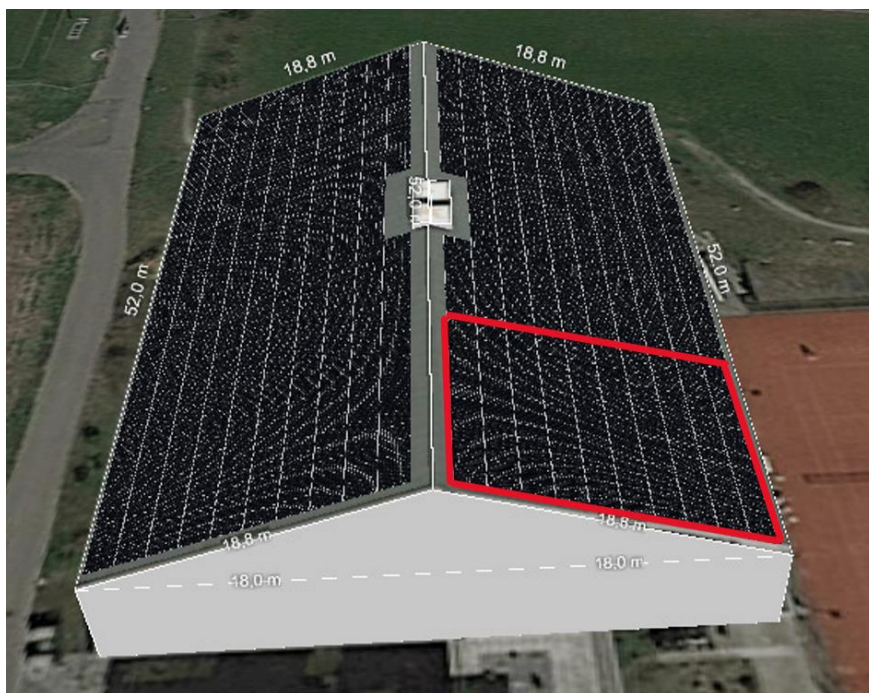
Bestehendes Hallendach mit Paneelen ausgestattet; rot eingerahmt die Anlage des Tennisclubs.
